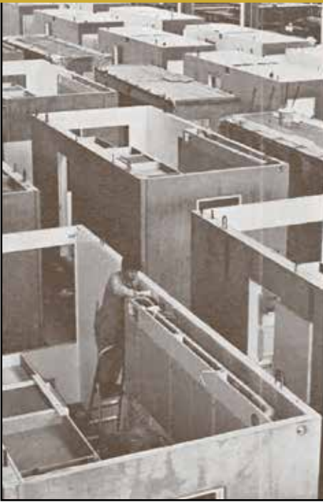
En fördel med Elementfabriken var att produktionen kunde pågå inomhus året om oavsett väder.
