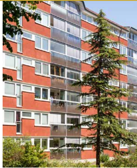
Husen i Landala som byggdes under miljonprogrammet har de senaste åren fått ny fasad.
