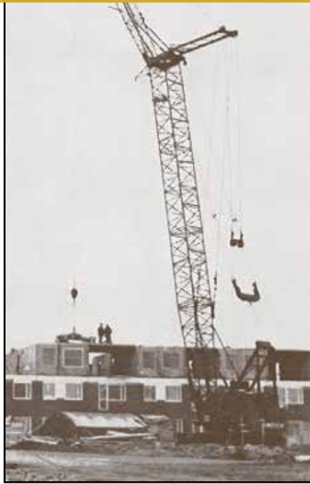
För att klara av att lyfta de stora elementen krävdes en rejäl lyftkran som togs till Göteborg från USA.
