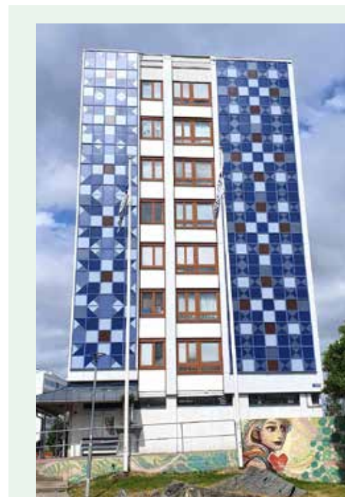
Designade solceller på fasaden ger ny energi.
