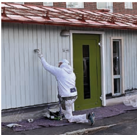
Två soprum byggdes ut och blev större, och ett helt nytt soprum byggdes till. Nu pågår det sista målningsarbetet.
