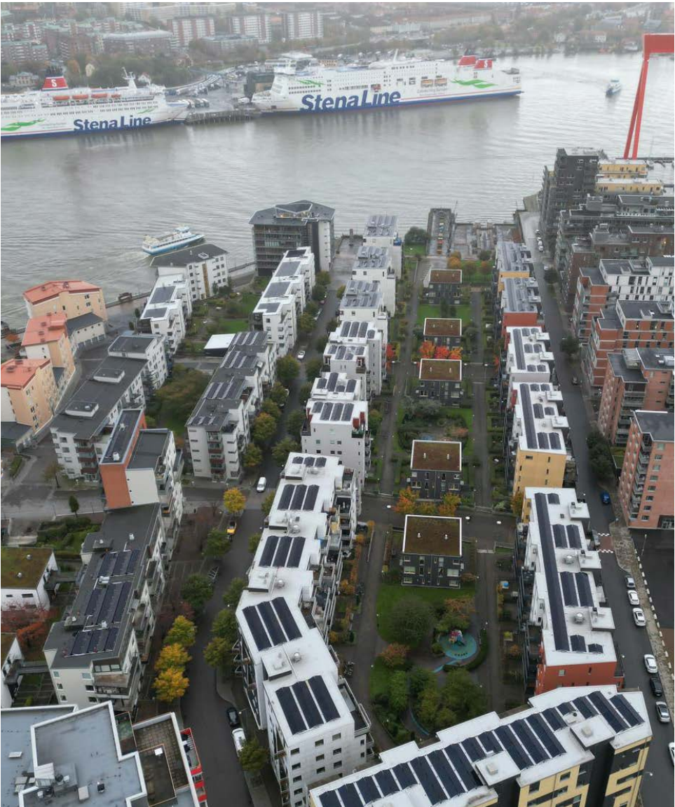
Våra hus på Eriksberg har fått nya solceller.
