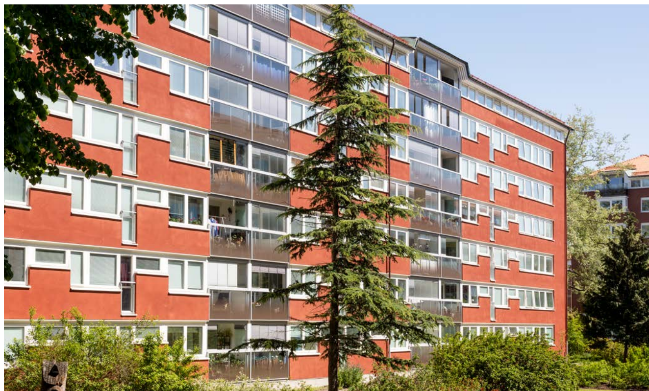
Husen i Landalabergen har fått nya fasader och fönster.
